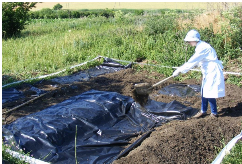
Imaginea 4. Extragerea solului contaminat.
